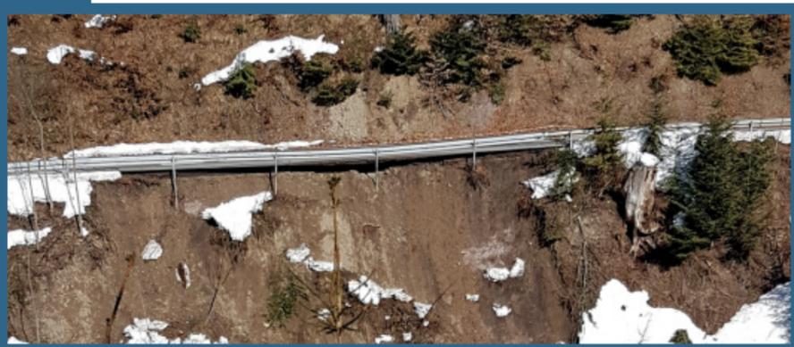
Durch eine Hangrutschung ist die Verbindungsstraße zwischen dem Imlauberg und dem Schartenberg nicht befahrbar. Die Straße muss bergseitig verlegt und auf einer Länge von ca. 130 Laufmeter neu gebaut werden. Die Sperre wird voraussichtlich bis Mitte Mai aufrecht bleiben.
